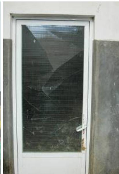
So sehen die vorhandenen Türen im inneren des Perrengebäudes schon lange aus. Sie sind verzogen, schließen nicht mehr richtig und die Scheiben sind zerbrochen. Die Griffe sind kaputt und viel zu dicht am Rahmen, so daß man sich die Hände bei öffnen und schließen aufschrammt. DIE MÜSSEN NEU!!!
